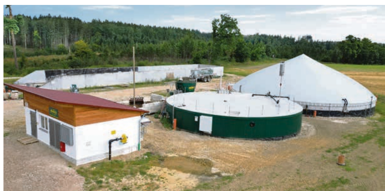
Die neue Gülle-Mist-Biogasanlage liefert jährlich rund 800.000 Kilowatt Strom.
