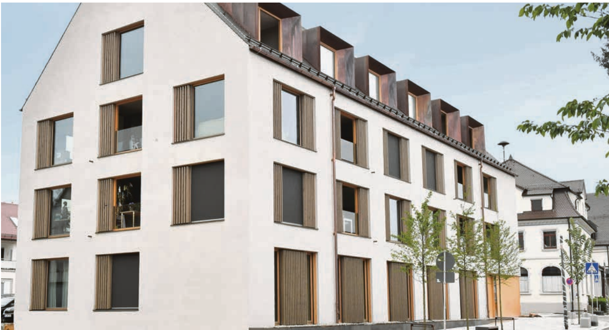
Das neue Gebäude in der Erlenbachstraße in Erbach beinhaltet neben der Bankfiliale auch 11 barrierefreie Wohneinheiten, die an das Fernwärmenetz angeschlossen sind.
